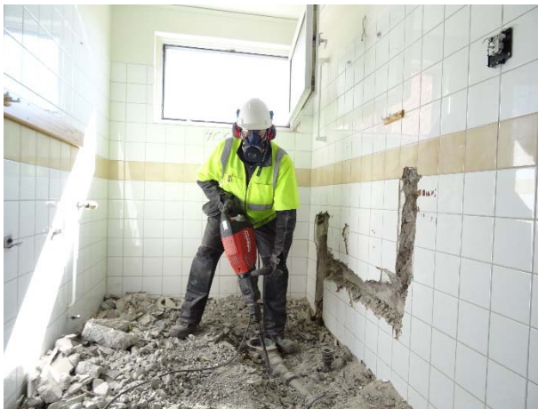
Bild 102 Uppbilning av avloppssystem
