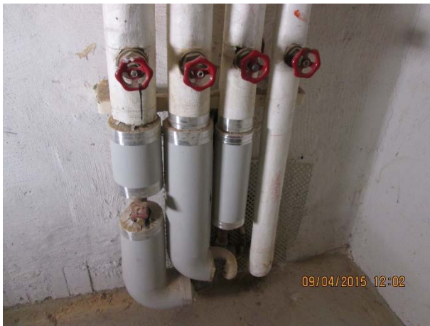
Bild 153 Inkommande kulvert i källaren under trapphus B
