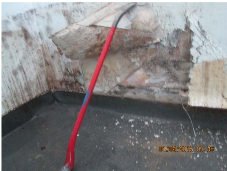
Bild 8 Mikrobiell påväxt bakom väv och bakomvarande ribbad plastmatta.
