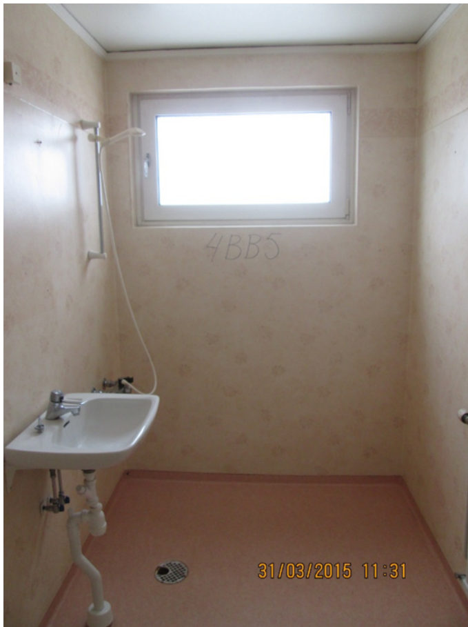
Bild 11 Våtrum med ny vägg- och golvmatta
