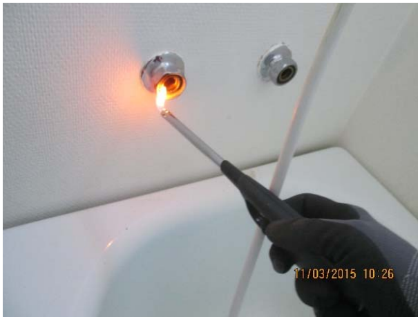
Bild 147 Sterilisering av rörändan
