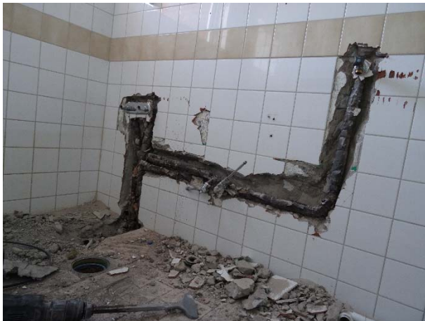
Bild 103 Utbilning av vattenrörssystem
