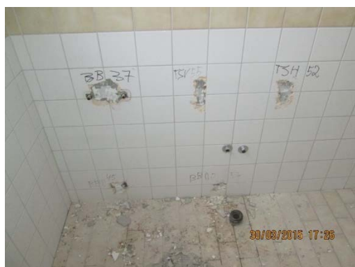
Bild 1 Mätplatser för indikationsmätning med Gann Hydromette Uni 1
